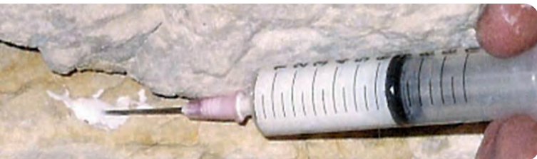
Hinterfüllen von Schalen mit Injektionsmörtel
