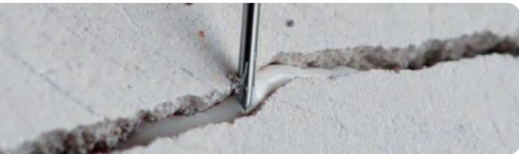
Füllen von Rissen
